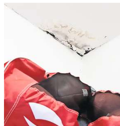
In der Sporthalle des OSZ Flakowski regnet es bei jedem etwas länger anhaltenden Regen durch.
